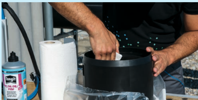
Maak de lasgebieden van de fitting en buis schoon met een schone doek en reinigingsmiddel.
