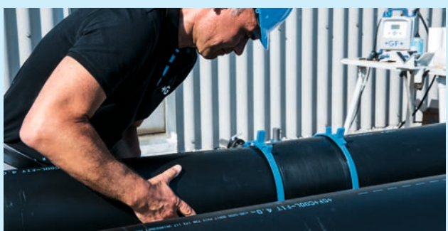
Schuif de uiteinden van de buis tot aan de markering in de fitting. Verwijder vervolgens de montagehulp.
