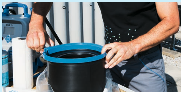
Plaats de montagehulp op de fitting. Rek de afdichtingslip uit door de handgrepen samen te drukken.
