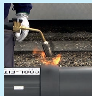
Dicht het verbindingvlak tussen de fitting en buis af met afdichtingstape en krimp de krimpmof.
