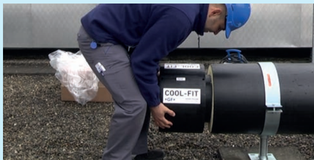
Schuif de krimpmoffen over de buis en duw de buiseinden tot aan de stop in de elektroasmof.
