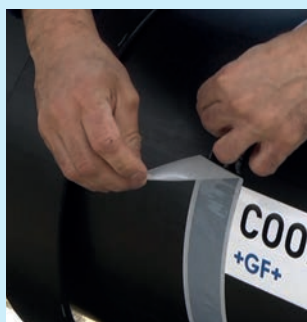
Dicht het verbindingvlak tussen de fitting en buis af met afdichtingstape en krimp de krimpmof.
