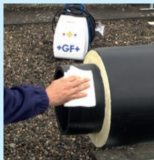
Schild de einden van de buis en fitting type B en maak de lasgebieden van de fitting en buis schoon met een schone doek en reinigingsmiddel.
