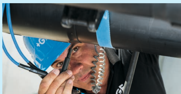
Sluit de laskabels aan op de lascontacten van de fitting en las volgens de handleiding.
