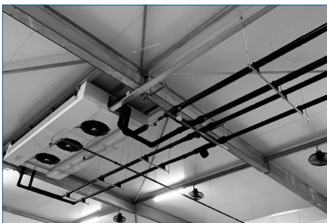
COOL-FIT 4.0 aansluiting verdamper
