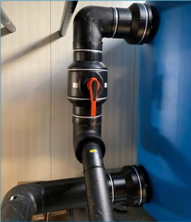
COOL-FIT 4.0 aansluiting op buffervat
