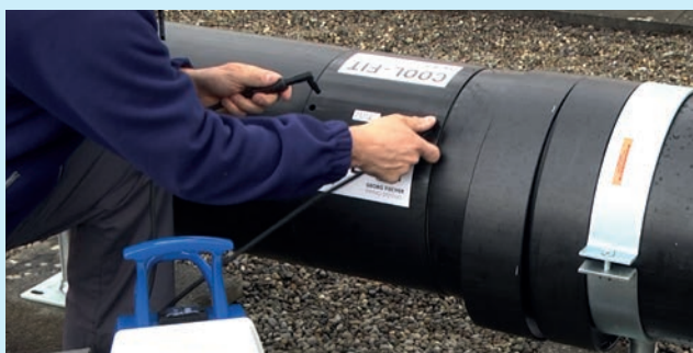
Sluit de laskabels aan op de lascontacten van de fitting en las volgens de gebruiksaanwijzing.
