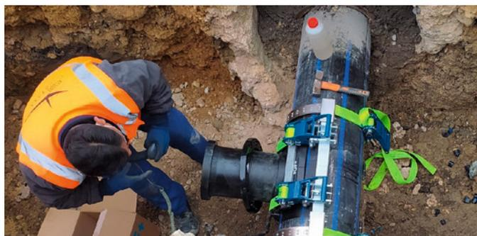
Das von GF Piping Systems gelieferte Topload-Werkzeug ermöglicht eine flexible Platzierung der Anschlusschellen, ohne dass die Rohre geschnitten werden müssen.
