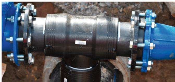
Die alten Faserzementrohre werden mit einem modernen Polyethylensystem neu ausgekleidet. Zum Anbringen von seitlichen Abgängen sind nur kleine Gräben erforderlich.
