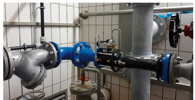
Die Leichtbau-Polymerlösung bietet eine längere betriebliche Nutzungsdauer bei minimalem Wartungsaufwand und befreit Techniker von zeit- und arbeitsintensiven Installationen im Vergleich zu schweren, duktilen Alternativen aus Eisenwerkstoff.
