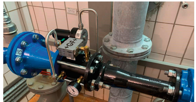
Schneller und einfacher Einbau Dank des leichten NeoFlow Polymer-Druckregelventils und der Zwischenflanschanordnung.
