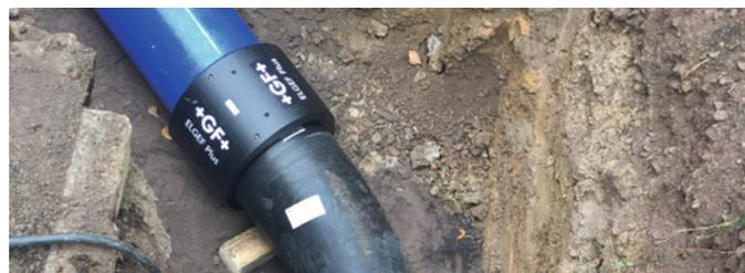
Installation der neuen Polyethylen Feuerlöschleitung.
