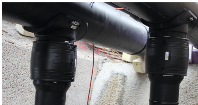
Einfach und schnell PE-Abzweige anschliessen: ELGEF Plus Schellen d450 mm x 225 mm.
