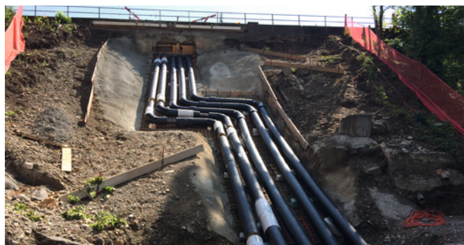
Teilabschnitt Torfeld Telli: 2 Stahl- und 3 PE-Leitungen.
