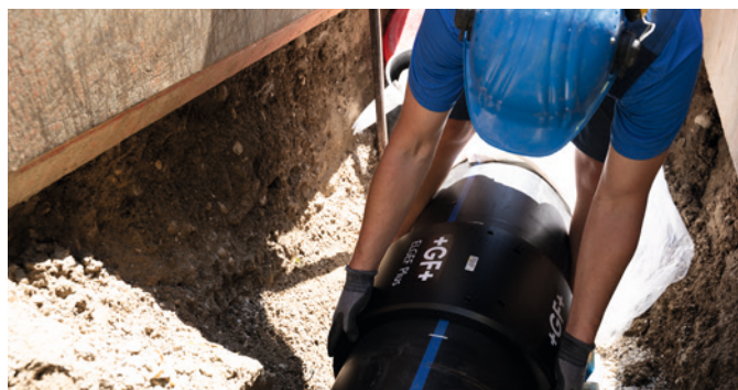
Der extra grosse Innendurchmesser der Muffe ermöglicht eine einfache Montage.
