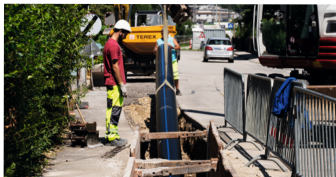
Einbindung eines 12m langen PE-Rohrs im Grabenverbau.
