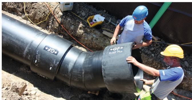
Vorgefertigte Segmentbögen werden luftdicht mit ELGEF Plus Muffen verbunden.
