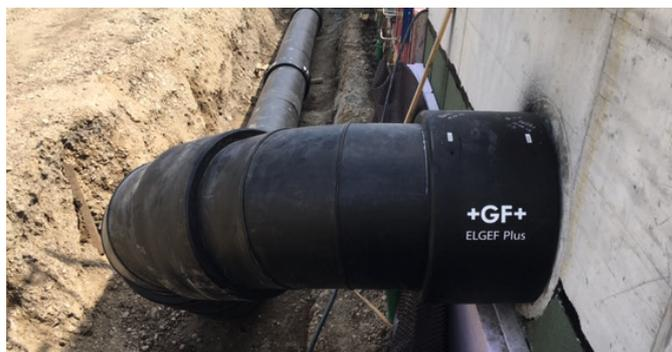
Enge Umlenkung der Frischluftleitung d710 mm direkt am Gebäude.
