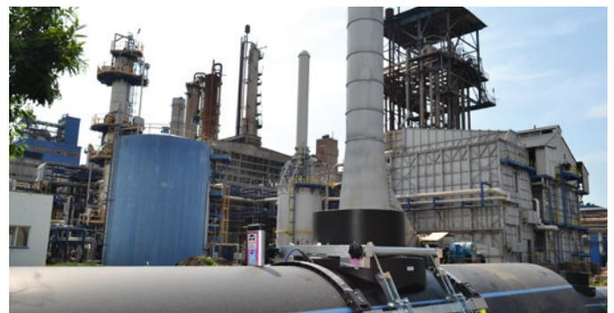
Schnelle Vor-Ort-Integration eines ELGEF Plus Sattels in der Dimension d1000 mm mit einem Abgang in der Dimension d500 mm.
