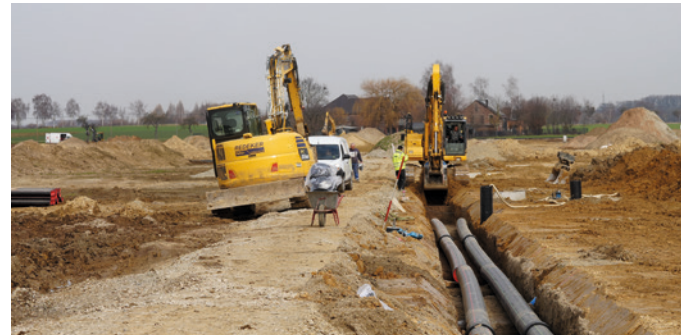
Im Neubaugebiet „Neuer Soester Norden“ werden Rohre verlegt, die später die Wärme aus dem Erdreich zu den 600 Wohneinheiten transportieren.
