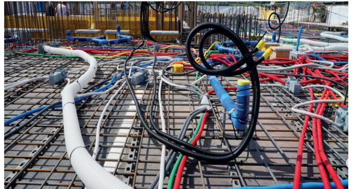
I tubi iFIT (neri) sono montati per la fornitura di acqua potabile degli appartamenti.
