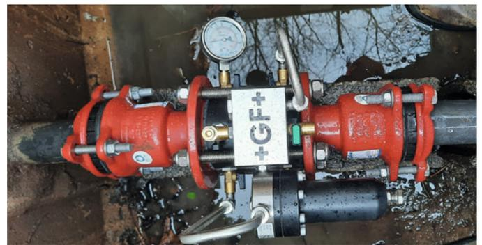
Dank seiner axial zur Durchflussrichtung gestalteten Bauform sorgt NeoFlow für einen stabilen Fluss bei 1% bis 100% Öffnung, selbst bei geringem Betriebsdifferenzdruck.
