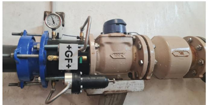
Dank seiner axial zur Durchflussrichtung gestalteten Bauform kann NeoFlow ausserdem die erforderlichen Löschwassermengen in Pecquencourt sicherstellen.
