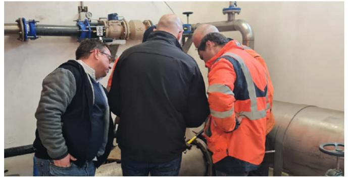
Das alte Druckregelventil aus Gusseisen wurde mit technischer Unterstützung von GF Piping Systems erfolgreich durch NeoFlow ersetzt.
