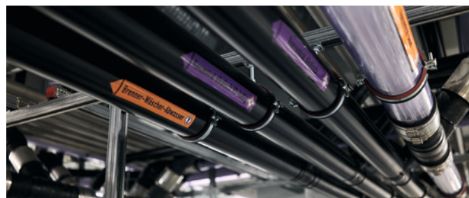
Mit auf die Eigenschaften des Mediums in der Produktionsanlage abgestimmten Kunststoffen ist CONTAIN-IT Plus korrosionsfrei und wartungsarm.
