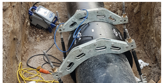
Einfach und zuverlässig: Im ELGEF Plus Elektroschweiss-System sind Schweissgerät, Werkzeuge und Fittings aufeinander abgestimmt.
