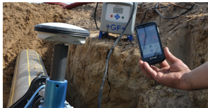
Track & Trace von GF Piping Systems: vollständige Rückverfolgbarkeit einschliesslich zentimetergenauer GPS-Positionierung der Verbindungen.
