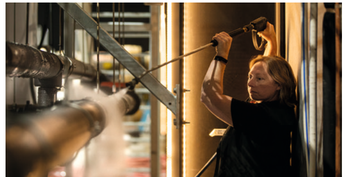
Dank fester Außenhülle und Dichtlippe kann das korrosionsfreie COOL-FIT System problemlos druckgereinigt werden.
