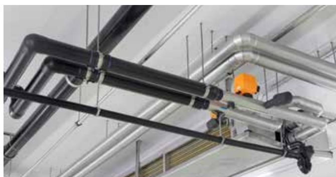
Das Rohrleitungs-Kühlsystem ist bei allen Komponenten bereits vorisoliert.
