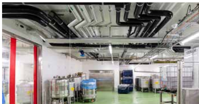
Das System wurde auf einer Strecke von ca. 150 Metern modernisiert.
