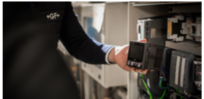
Der 9950 Sechs-Kanal-Transmitter reduziert Fehlerquellen und vereinfacht die Überwachung kritischer Parameter.
