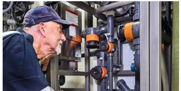
Die bordeigene Wasseraufbereitungsanlage versorgt das 174 Meter lange Schiff mit hygienisch reinem Wasser.
