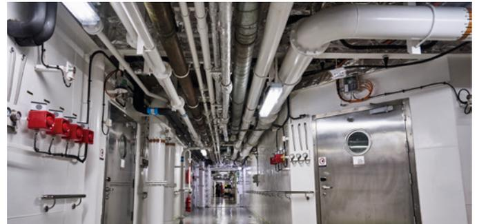
Auf der Global Mercy sind rund fünf Kilometer thermoplastische Rohre verlegt.
