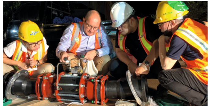
Montage des Rohrleitungssystems und Anpassung an die bestehende Hauptwasserleitung.
