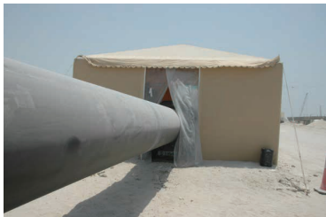
Schweissbereich mit einem Zelt schützen
