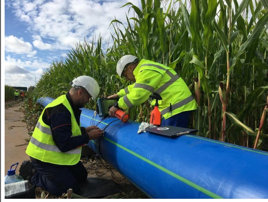
Teste Não Destrutivo de tubulações em PE durante a instalação sem abertura de valas.
