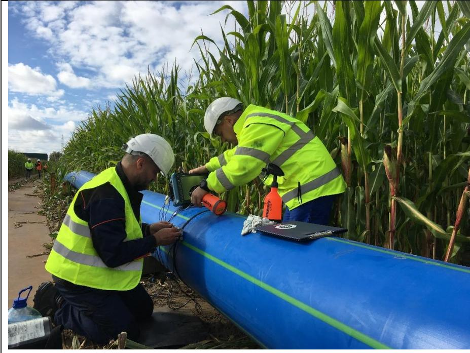
Prove NDT (Non-Destructive Testing) di tubazioni in PE durante un'installazione trenchless.
