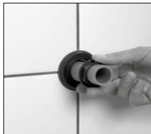
Inserire l'anello d'identificazione del fluido rosso o blu sulla flangia cieca ed infilarlo nel tubo di protezione. Inserire il dado di raccordo all'estremità del tubo ed avvitare manualmente di due giri. Infine, avvitare il dado con chiave per viti finché la guarnizione poggi uniformemente.
