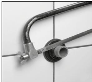
Inserire il dado esagonale prolunga stelo valvola dritto nel tubo di protezione e ripiegare fino alla battuta tramite il dado esagonale della parte superiore della valvola.
