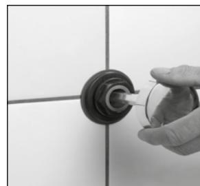
Emboîter la prolonge de la tige du robinet raccourcie dans l'hexagone de la rosace du volant. Introduire la rosace avec la prolonge d' entraînement dans la gaine de protection et l'insérer sur l'hexagone de la tige du robinet. Clipser la rosace sur la bride terminale.
