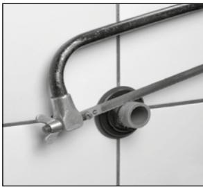
Das Schutzrohr an Vorderkante der Anschlussmutter bündig ablängen.
