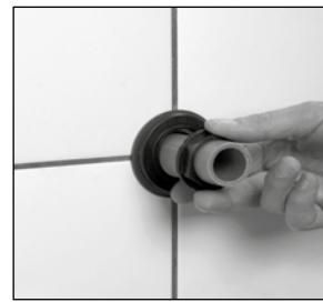
Emboîter l'anneau central de repérage rouge ou bleu sur la bride terminale et le diriger sur la gaine de protection. Poser l'écrou de raccordement sur l'extrémité du tube et visser directement à la main à l'aide de deux tours. Ensuite visser l'écrou à l'aide d'une clé à écrou universelle jusqu'à ce que le joint repose de manière régulière.
