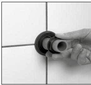
Den roten oder blauen Medium-Kennring auf den Abschlussflansch stecken und über das Schutzrohr führen. Anschlussmutter auf das Rohrende aufsetzen und zwei Umdrehungen von Hand aufschrauben. Anschliessend die Mutter mit einem Schraubenschlüssel so weit aufdrehen, bis die Dichtung am Abschlussflansch gleichmäßig an der Wand aufliegt.
