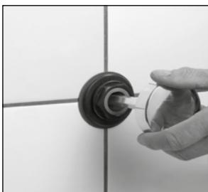
Die gekürzte Ventilstangen-Verlängerung in den Sechs-kant der Handradrosette stecken, in das Schutzrohr einführen und über den Sechskant der Ventilstange stecken. Die Rosette auf den Abschlussflansch einklinken.
