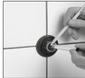
Introduire la prolonge d' entraînement directement dans la gaine de protection et l'insérer sur l'hexagone du chapeau du robinet jusqu'en butée.
