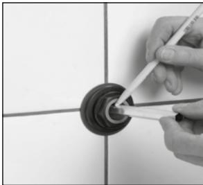
Die sechskant Ventilstangenverlängerung in das Schutzrohr einführen und bis zum Anschlag über den Sechskant der Ventilstange stecken. Die Vorderkante der Überwurfmutter bündig anzeigen, rechtwinklig ablängen und entgraten.
