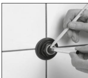
Inserire la prolunga dello stelo della valvola accorciata nel dado esagonale della rondella del volantino. Inserire la rondella con la prolunga di azionamento nel tubo di protezione e ripiegare tramite il dado esagonale della parte superiore della valvola. Fissare la rondella alla flangia cieca.
