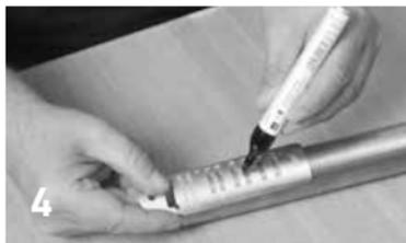
La profondeur d'insertion doit être marquée sur le tube avec l'outil de vérification.
