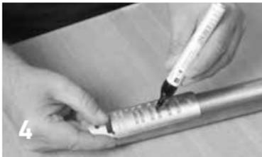
Mit dem Einstecktiefenwerkzeug ist die Einstecktiefe auf dem entsprechenden Rohr zu markieren.
