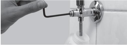
6. Probenahmerohr demontieren und Verschlusszapfen montieren.
