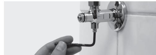
3. Probenahmerohr (Messing) handfest einschrauben.
