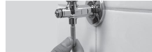
4. Probenahmerohr und Anschlussstutzen vom Probenahme-Eckventil vorsichtig abflammen.
