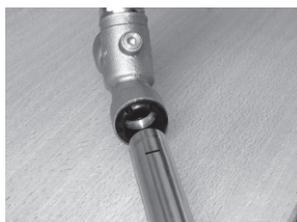
4 Contrôler visuellement le raccord pour vérifier sa propreté et l'assise correcte du joint torique avant d'insérer le tuyau. Insérer le tuyau jusqu'au marquage avec un léger mouvement de rotation.
