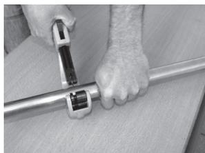
1 Couper le tuyau en cuivre ou en acier inox à la longueur désirée avec un coupe tube ou une scie.
