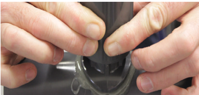
Schelle fest auf Rohrleitung drücken
