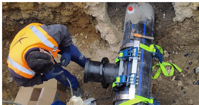
A ferramenta de fixação de instalação fornecida pela GF Piping Systems permite a instalação rápida de selas de derivação sem a necessidade de cortar os tubos.
