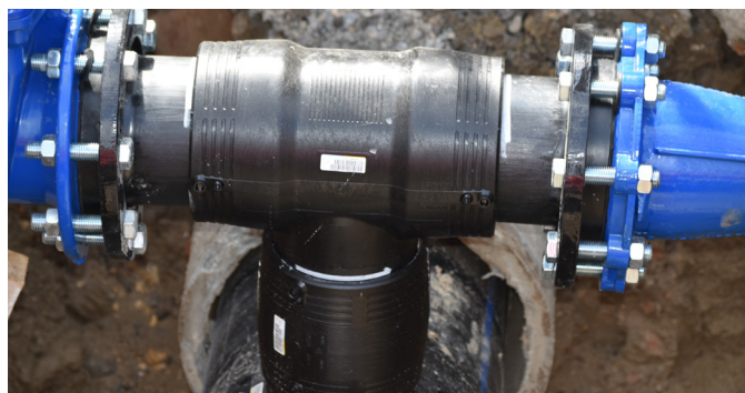
Os antigos tubos de fibrocimento são revestidos com um moderno sistema de polietileno. Apenas pequenas valas são necessárias para conectar as saídas laterais.
