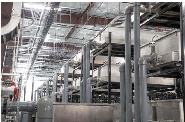
O ChlorFIT, fabricado com CPVC Corzan®, é um sistema de tubulação Schedule 80 altamente robusto e resistente à corrosão que oferece confiabilidade superior e desempenho duradouro em aplicações comerciais e industriais.
