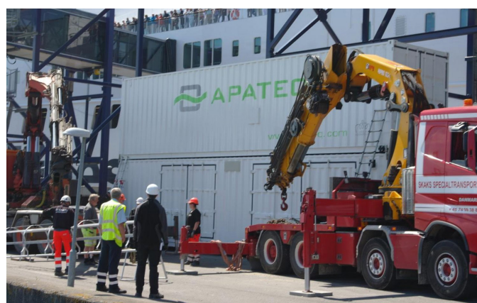
Instalação em terra do MarinePaq em contêineres no porto da Dinamarca.
