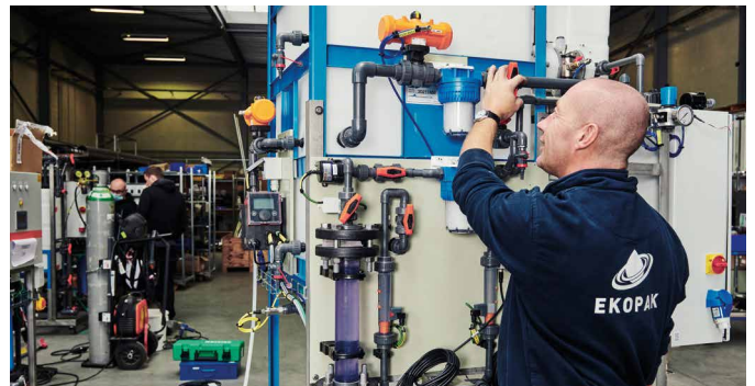
Um skid de tratamento de água sendo preparado pela Ekopak na Bélgica.
