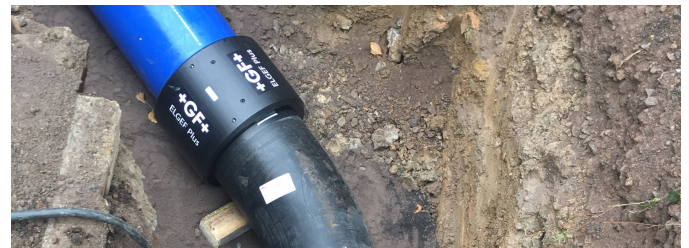
Instalação da nova tubulação de polietileno para combate a incêndios.
