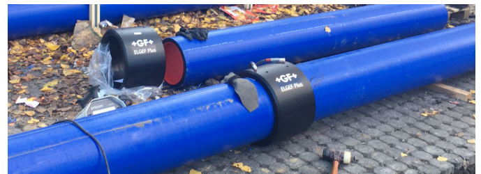
Montagem simples dos acopladores ELGEF Plus graças ao grande diâmetro interno.
