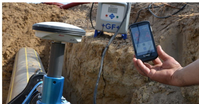
Track & Trace da GF Piping Systems: Rastreabilidade total, incluindo localização por GPS, com precisão de 1 cm, das soldas.
