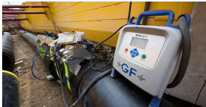
Instalação dos componentes no local da Max Schetter AG.
