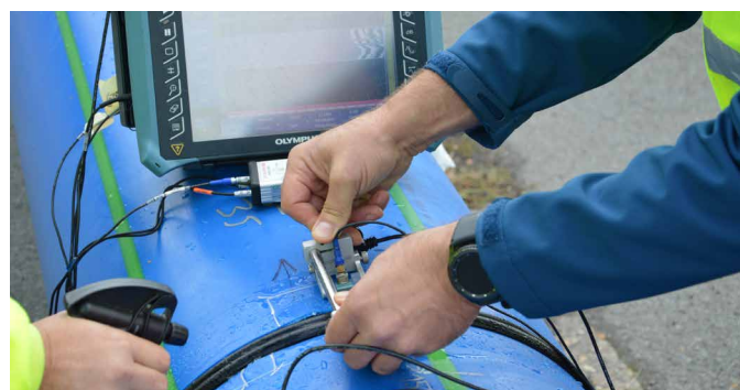
100% de teste NDT ultrassônico nas conexões de solda de topo de d500 mm na passagem do HDD.
