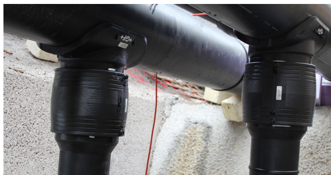
Conexão simples e rápida: Selas de ramal ELGEF Plus d450 mm x 225 mm.
