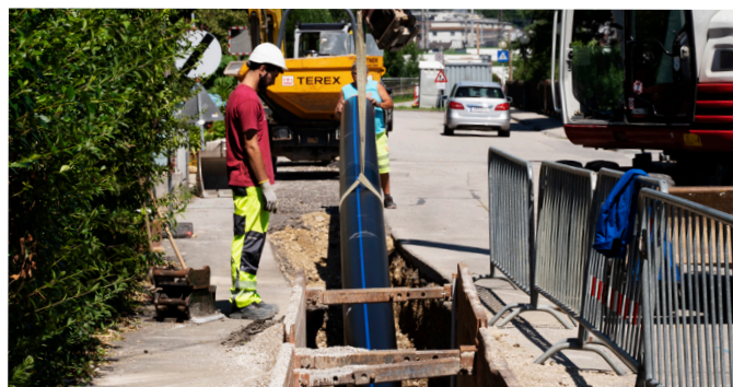
Integração de um tubo PE de 12 m de comprimento numa operação de escoramento de vala.
