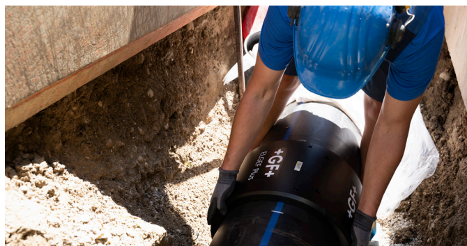
O diâmetro interno extragrande do acoplador permite uma montagem fácil.
