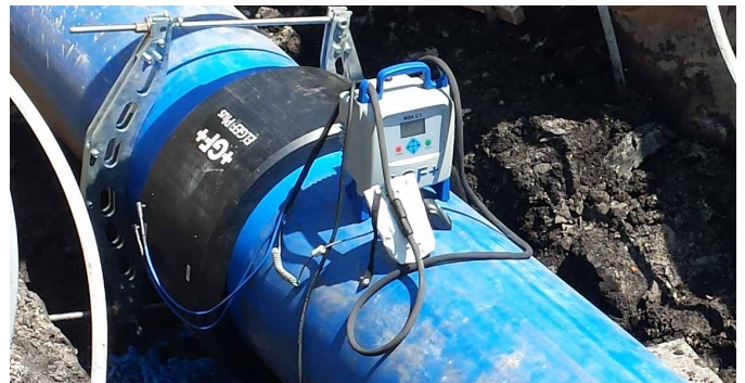
Conjunto completo: Conexões ELGEF Plus, ferramenta de torneamento e máquina de solda MSA.
