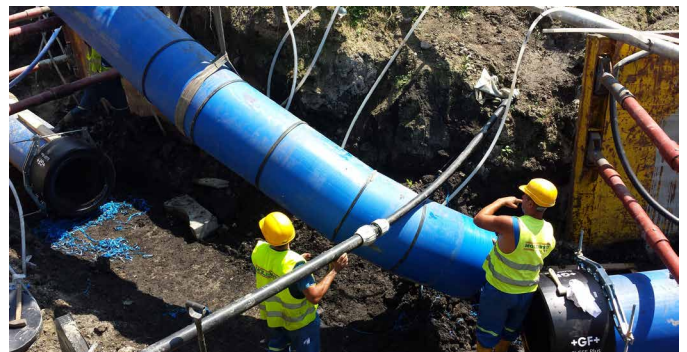
Integração no local de uma curva segmentada através do fácil deslocamento dos acopladores ELGEF Plus.
