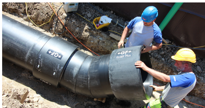
Os arcos segmentados pré-fabricados foram conectados usando acopladores ELGEF Plus, para garantir que o sistema seja hermético.
