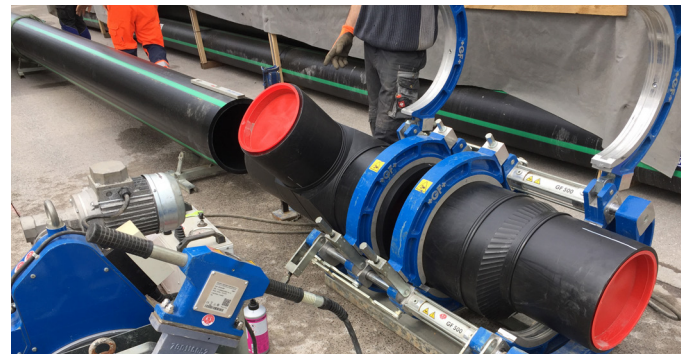
Simple e confiável: máquina de solda de topo GF 500 e conexões GF.
