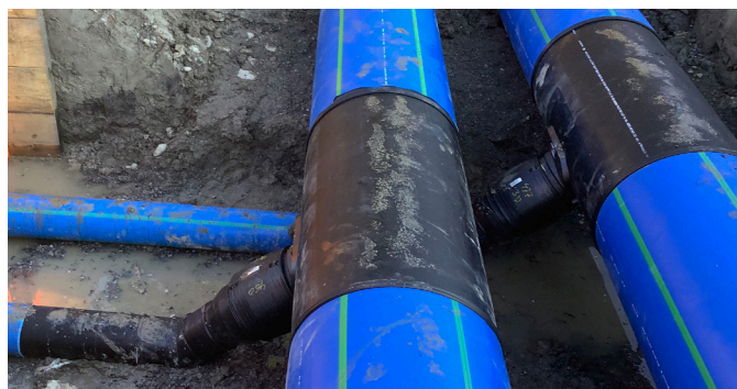
Seguro e eficiente: peças em T fabricadas na fábrica podem ser usadas para criar ramos na vala de forma simples, rápida e confiável.
