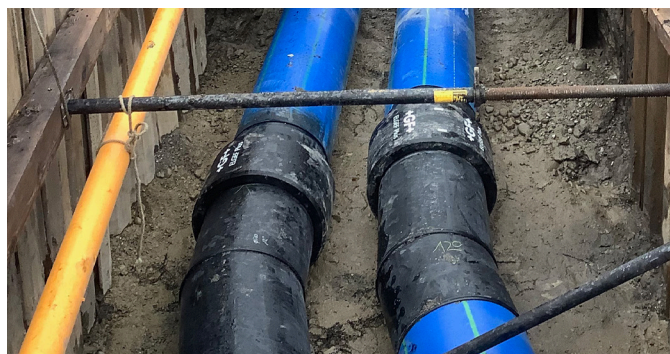
Sem problemas e econômico: Conexões de ponto fixo com acopladores ELGEF Plus.
