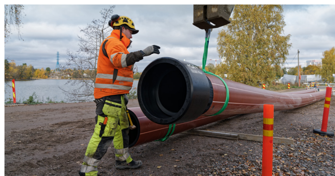
Instalação fácil e rápida do acoplador de eletrofundição ELGEF Plus.
