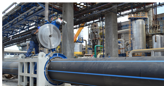
Qualidade de união confiável com as máquinas de solda de topo da GF Piping Systems.
