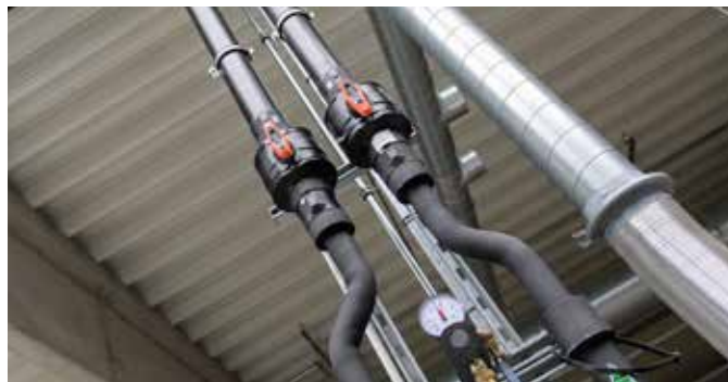
As válvulas de esfera tipo 546 em uso na gráfica
