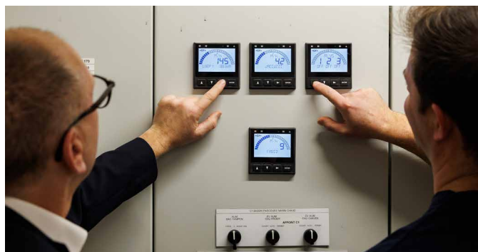
Transmissores como o 9900 permitem que o Sofitel Quiberon garanta a correta vazão de água em várias aplicações.
