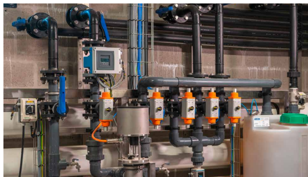
As válvulas borboleta equipadas com atuadores pneumáticos ou elétricos são usadas como válvulas de processo e controle.
