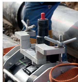
Entre os componentes usados no projeto de sustentabilidade estão as válvulas de controle de pressão da GF Piping Systems. Essas válvulas podem ser giradas em 360° antes da solda.
