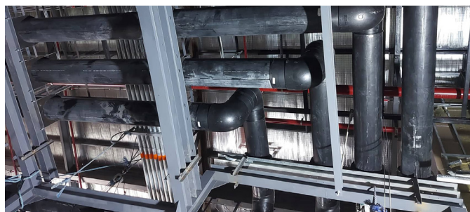
Mais de 11.000 conexões PE100 livres de corrosão ajudam a reduzir as emissões de carbono do NARRA 1 em mais de 135.000 kg de CO 2 .
