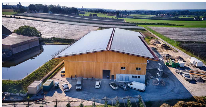
A instalação de armazenamento com temperatura controlada naturalmente amplia a disponibilidade de produtos de alta qualidade.
